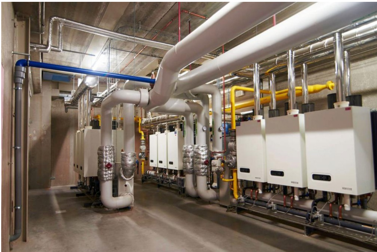
Рис.4 Пример каскадной схемы в котельной
